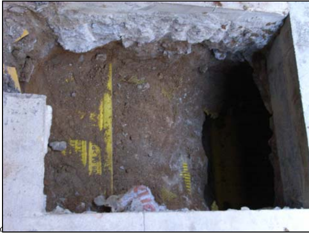
FOTO 1. Cala al carrer amb els serveis documentats.
